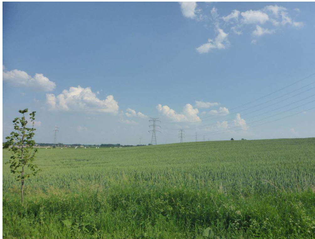
Zdj. 12 – Linia 400 kV Ełk – Łomża w rejonie msc. Prostki
