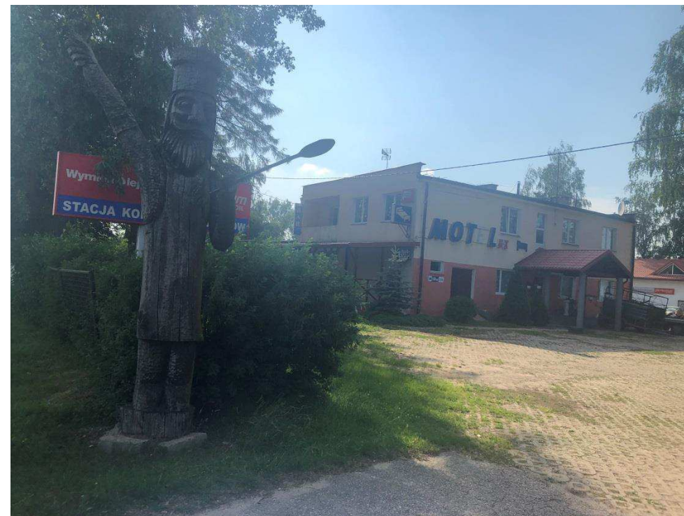
Zdj. 9 – Zjazd na DK65 w miejscowości Toczyłowo (lp. 9)
