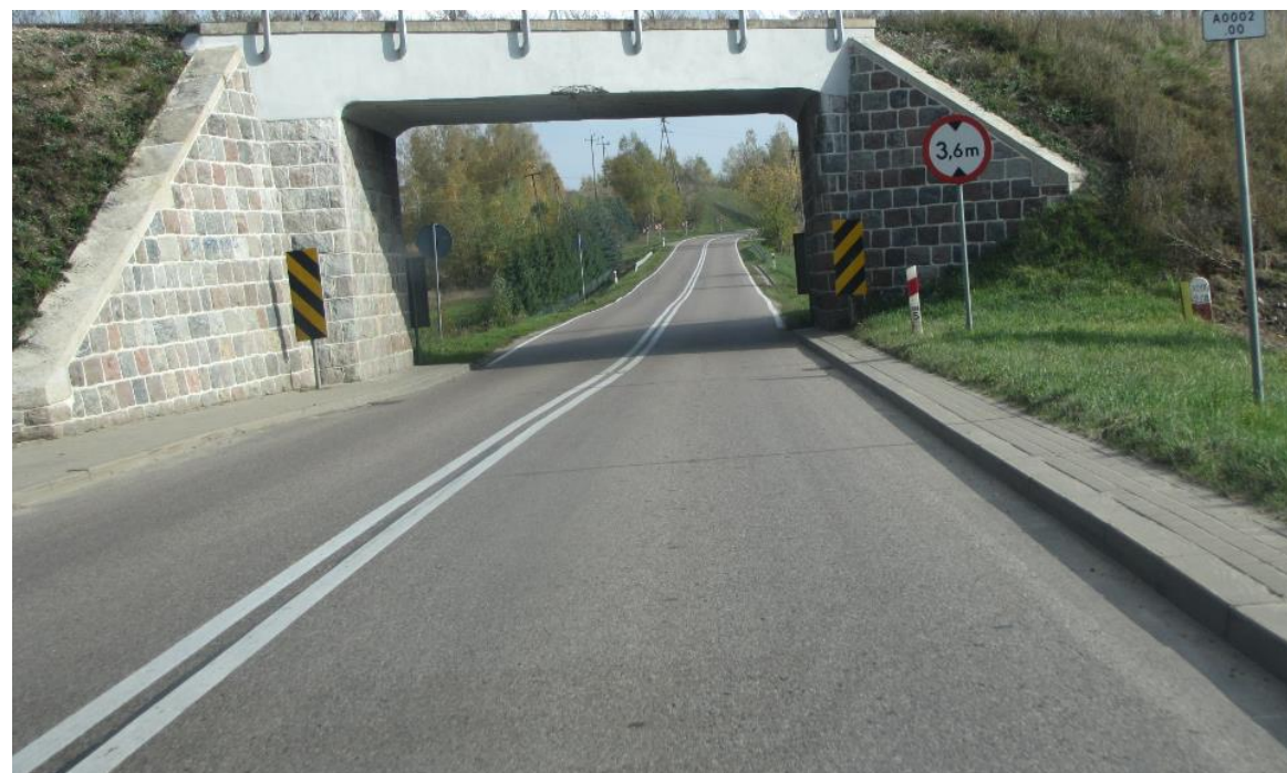
Fotografia 8 Km 222+500 – wiadukt kolejowy
