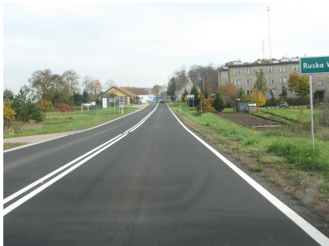
Fotografia 28 Km 280+700 – przebieg istniejącej drogi przez miejscowość Ruska Wieś
