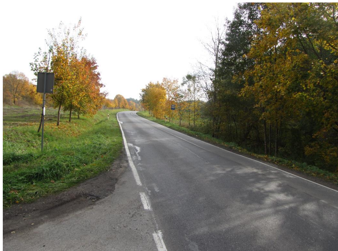
Fotografia 1 207+460 Początkowy odcinek drogi dk16
