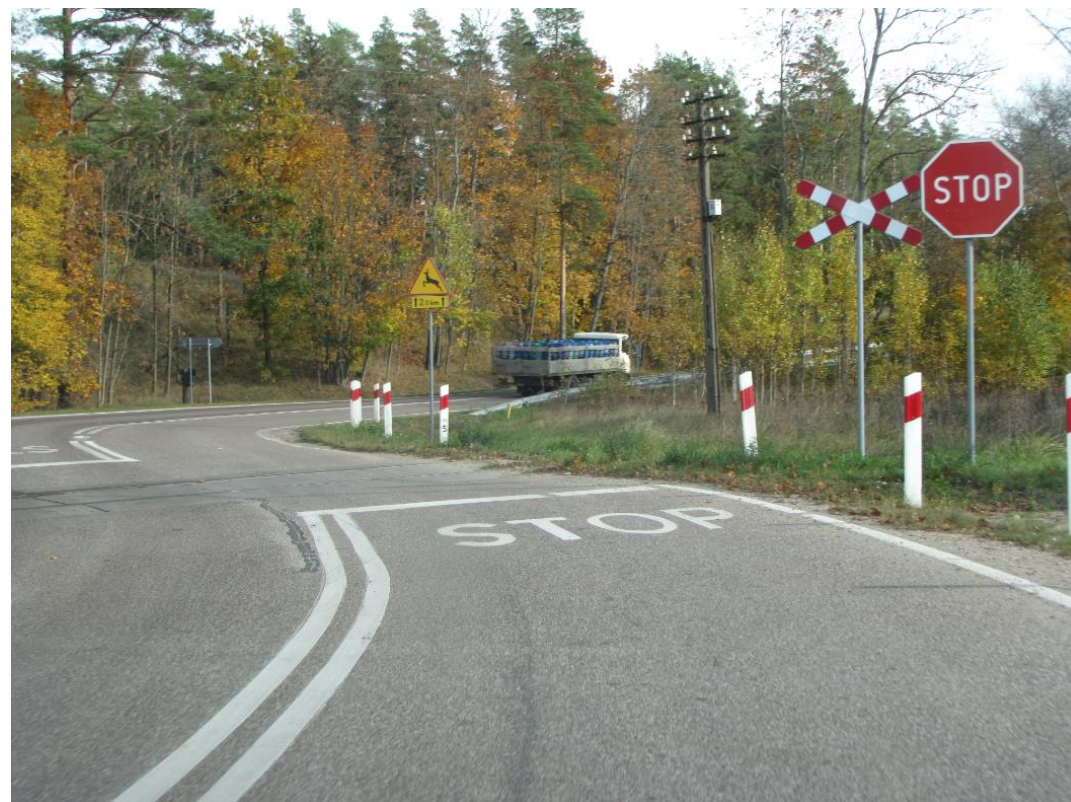
Fotografia 19 Km 251+510 – przejazd kolejowy
