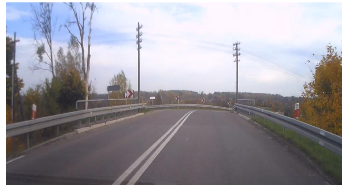
Fotografia 3 Km 213+620 – wiadukt nad linią kolejową Olsztyn – Elk
