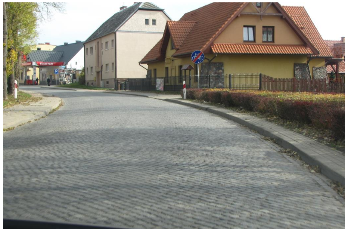
Fotografia 11 Km 227+000 – nawierzchnia brukowa w miejscowości Mikołajki
