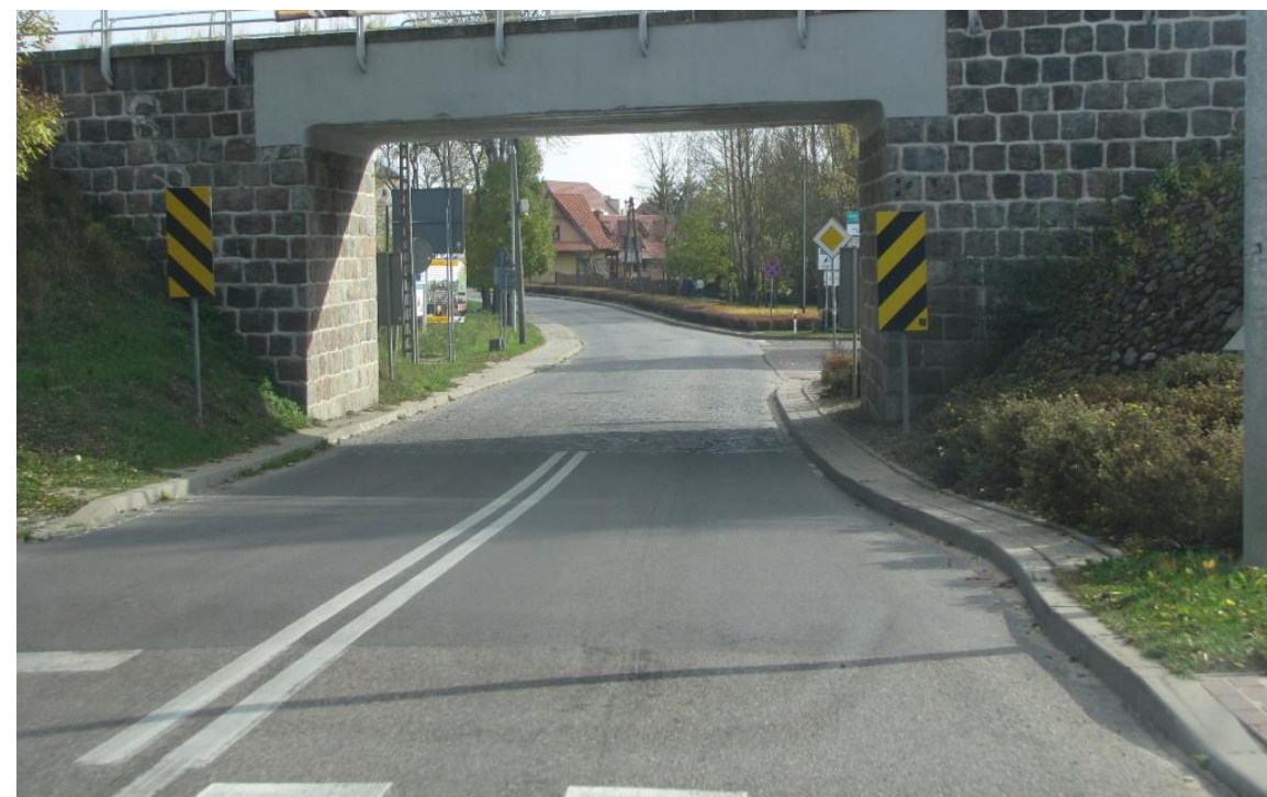
Fotografia 10 Km 226+840 – wiadukt kolejowy w miejscowości Mikołajki
