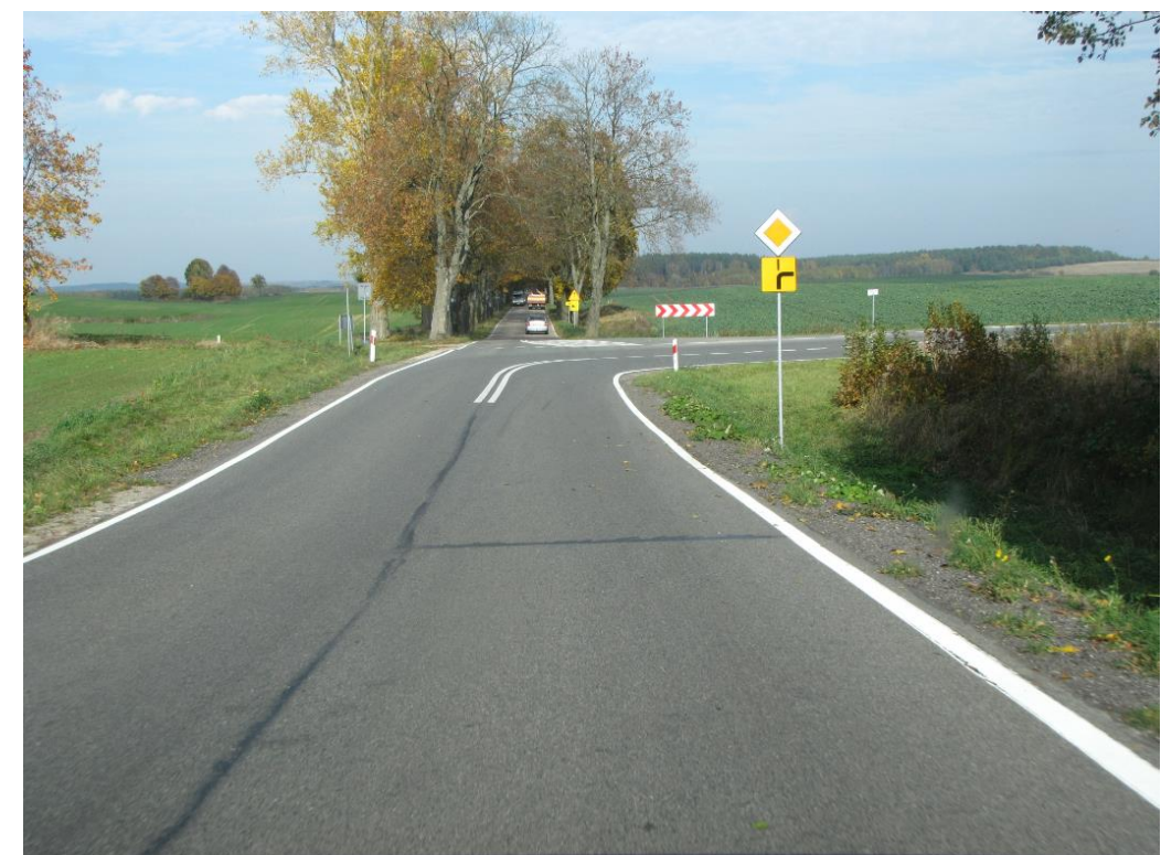
Fotografia 15 Km 237+300 – skrzyżowanie DK16 z DW643
