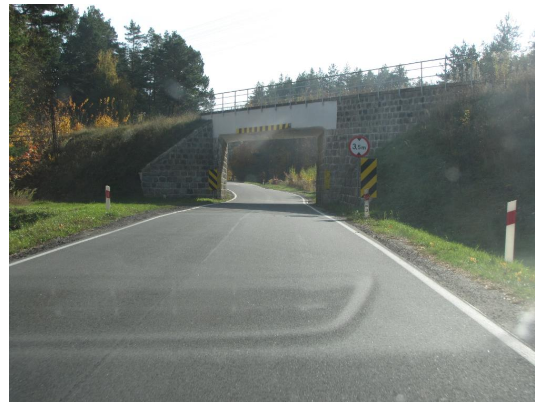
Fotografia 18 Km 248+300 – wiadukt kolejowy
