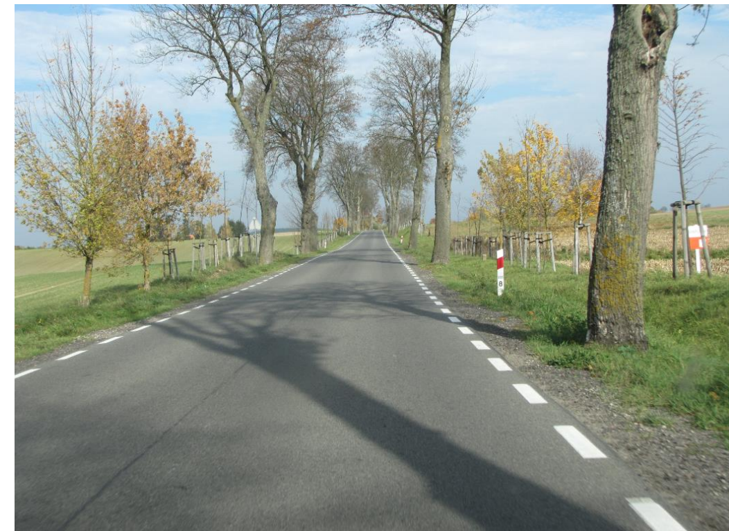
Fotografia 14 Km 235+800 – drzewa blisko krawędzi jezdni
